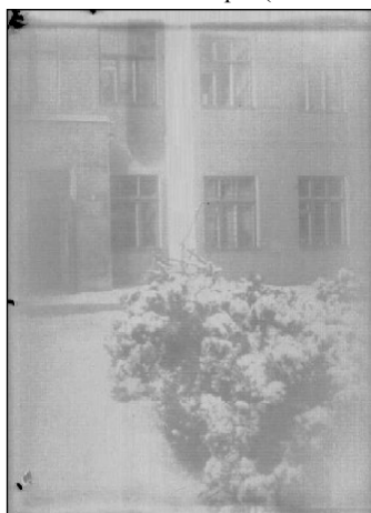
Рис. 4. Изображение здания корпуса №5 Каменец-Подольского национального университета
